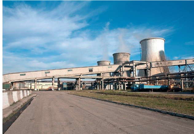
Benzile inclinate de carbune 7A si 7B care fac legatura intre gospodaria de carbune (cota 0) si sala cazanelor (cota +46)
